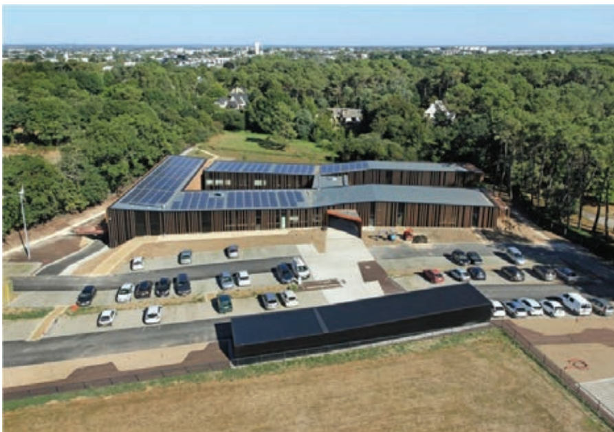
Figure 1. Vue du site du bâtiment Kergrid
