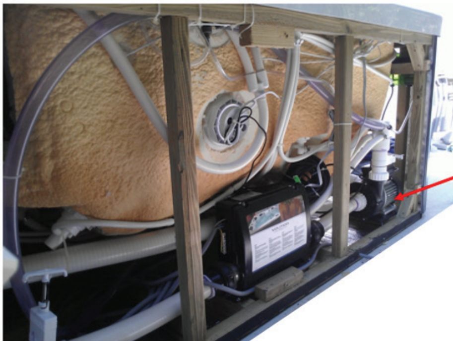
pompe de circulation
